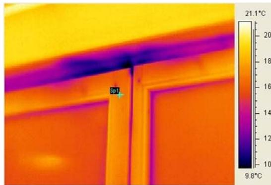
Die Thermographie-Aufnahmen dieses Wohnhauses stellen Wärmeenergieverluste u. a. im Bereich der Fenster recht deutlich dar, die außer den baukonstruktiv und baustofflich bedingten Wärmebrücken auch durch Luftundichtigkeiten im Fensteranschlussbereich (mangelhafte Fugenabdichtung) entstehen und somit die geforderte Luftdichtheit gemäß Energieeinsparverordnung unterstreichen.
