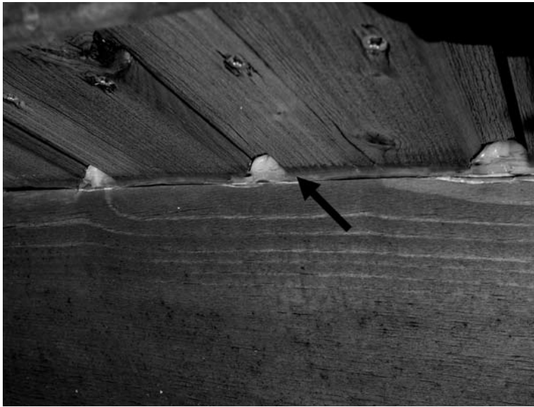
Bild 14: Mangelhafte Fugendimensionierung am Anschluss der Nut- und Federbretter zum unteren Holzbalkenabschluss (nicht maßhaltige Bauteile im Außenbereich dürfen nicht mit spritzbaren Dichtstoffen abgedichtet werden).
