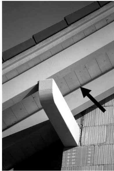
Bild 7: Dachuntersichten - Abdichtung des überstehenden Schrägdachs zum Tragebalken
