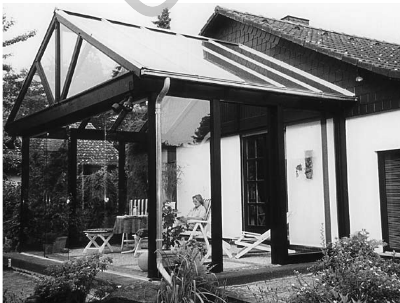
Bild 6: Wintergarten, Anschluss der Holzbalken zum geputzten Baukörper
