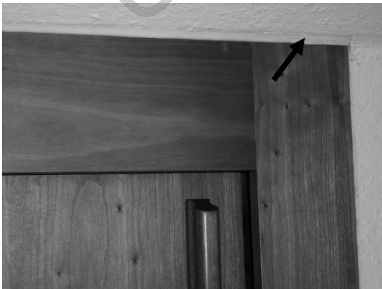
Bild 9: Einbauschränk, Abdichtung gegen Dachschräge
