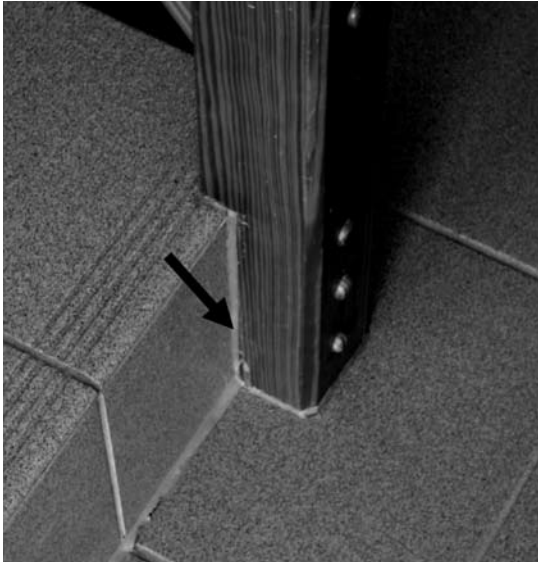
Bild 12: Abdichtung zwischen Treppenfuß und Bodenbelag
