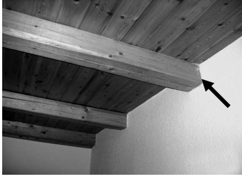
Bild 10: Deckenbalkendurchführung in die Wand
