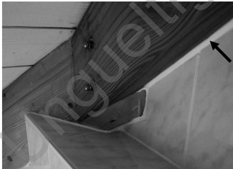
Bild 11: Abdichtung von Deckenbalkenkonstruktion gegen Fliesenbelag
