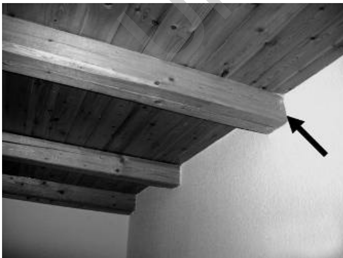
Bild 10 Deckenbalkendurchführung in die Wand
