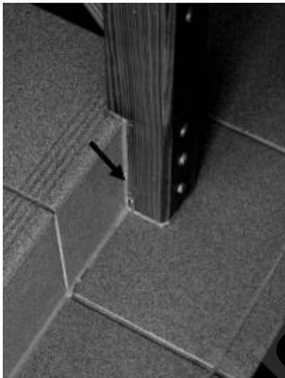
Bild 12: Abdichtung zwischen Treppenfuß und Bodenbelag
