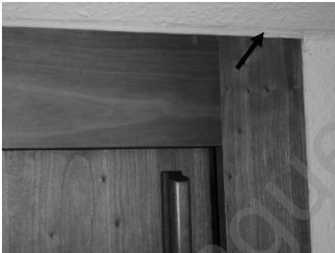
Bild 9 Einbauschränk, Abdichtung gegen Dachschräge
