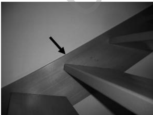
Bild 13: Abdichtung einer Treppenwange zur Wand
