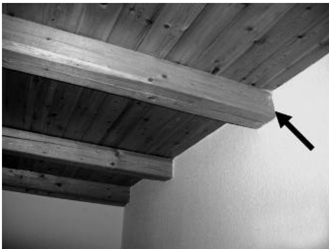
Bild 10 Deckenbalkendurchführung in die Wand
