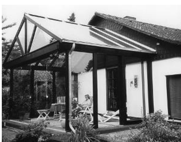
Bild 6: Wintergarten, Anschluss der Holzbalken zum geputzten Baukörper
