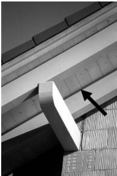
Bild 7: Dachuntersichten - Abdichtung des überstehenden Schrägdachs zum Tragebalken
