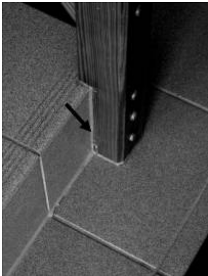
Bild 12: Abdichtung zwischen Treppefuß und Bodenbelag
