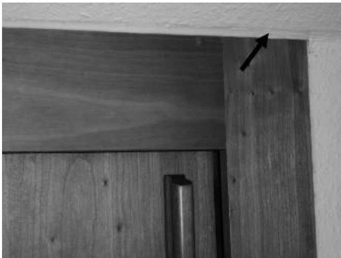
Bild 9 Einbauschränk, Abdichtung gegen Dachschräge
