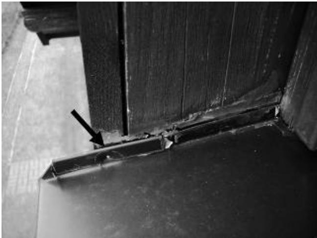
Bild 16: Kohäsionsrisse im Dichtstoff zwischen Metallprofil und Holzwand aufgrund zu starker Fugenbewegung
