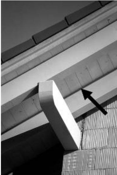
Bild 7: Dachuntersichten - Abdichtung des überstehenden Schrägdachs zum Tragebalken
