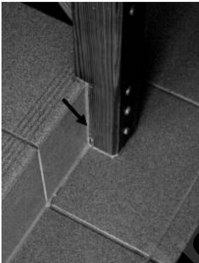
Bild 12: Abdichtung zwischen Treppenfuß und Bodenbelag
