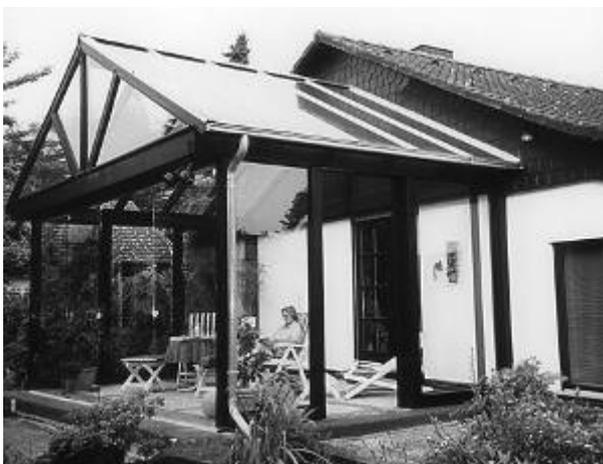
Bild 6: Wintergarten, Anschluss der Holzbalken zum geputzten Baukörper
