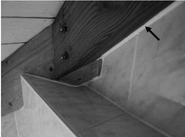
Bild 11: Abdichtung von Deckenbalkenkonstruktion gegen Fliesenbelag
