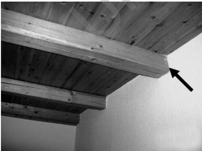
Bild 10 Deckenbalkendurchführung in die Wand
