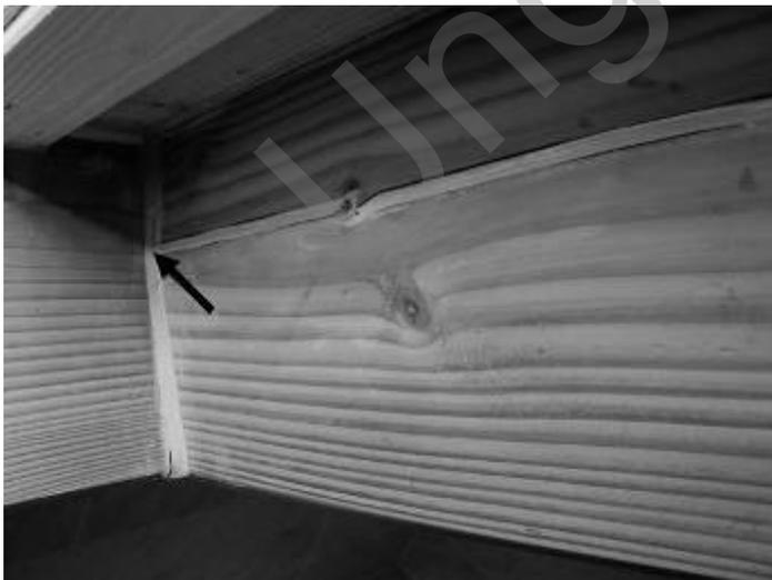
Bild 8: Das Verschließen von Rissen im Holz ist nicht zu empfehlen
