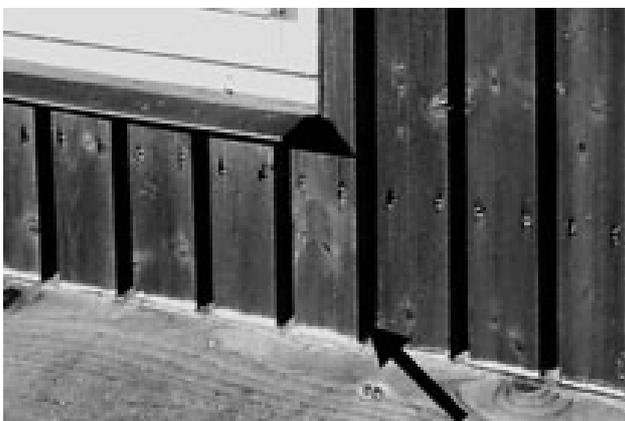
Bild 15: Kohäsionsrisse im Dichtstoff durch zu starke Bewegung der nicht maßhaltigen Holzbauteile
