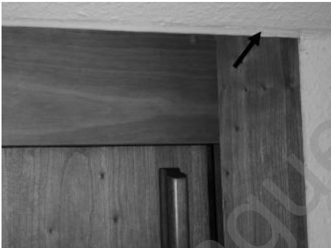
Bild 9 Einbauschränk, Abdichtung gegen Dachschräge
