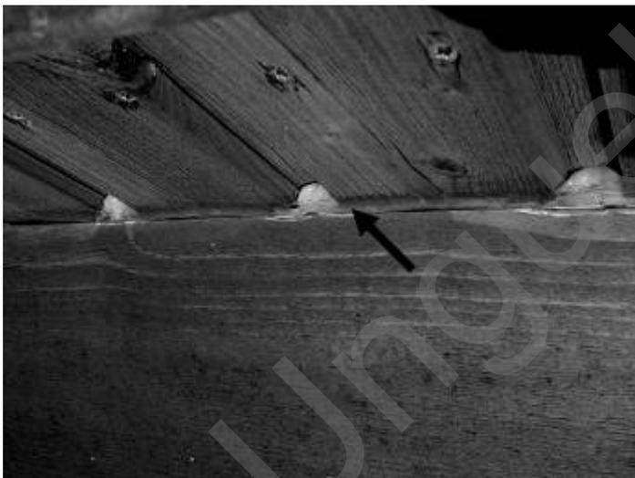
Bild 14: Mangelhafte Fugendimensionierung am Anschluss der Nut- und Federbretter zum unteren Holzbalkenabschluss (nicht maßhaltige Bauteile im Außenbereich dürfen nicht mit spritzbaren Dichtstoffen abgedichtet werden)
