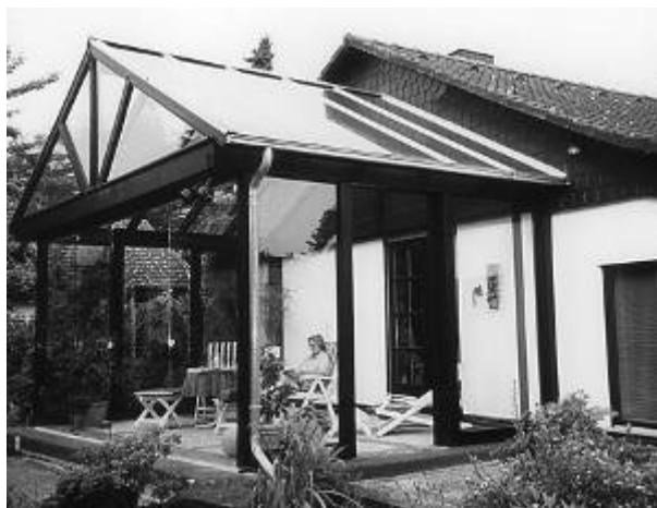
Bild 6: Wintergarten, Anschluss der Holzbalken zum geputzten Baukörper
