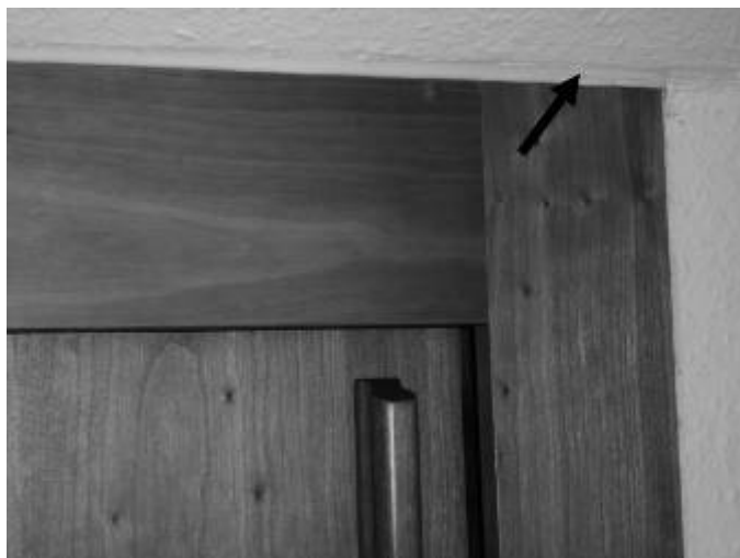
Bild 9 Einbauschränk, Abdichtung gegen Dachschräge
