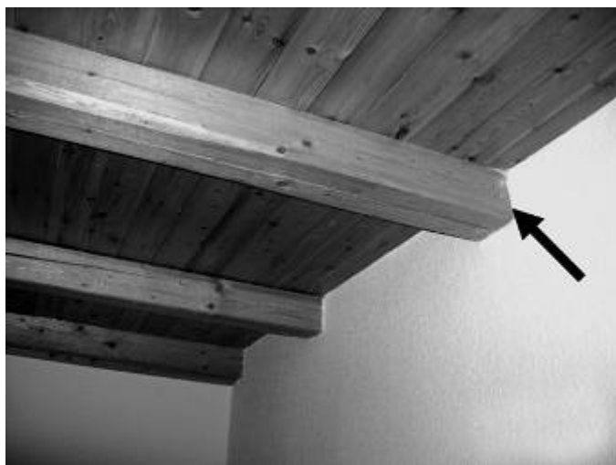
Bild 10 Deckenbalkendurchführung in die Wand
