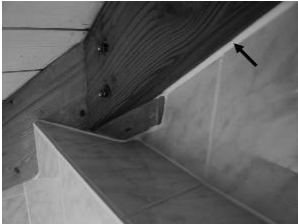
Bild 11: Abdichtung von Deckenbalkenkonstruktion gegen Fliesenbelag
