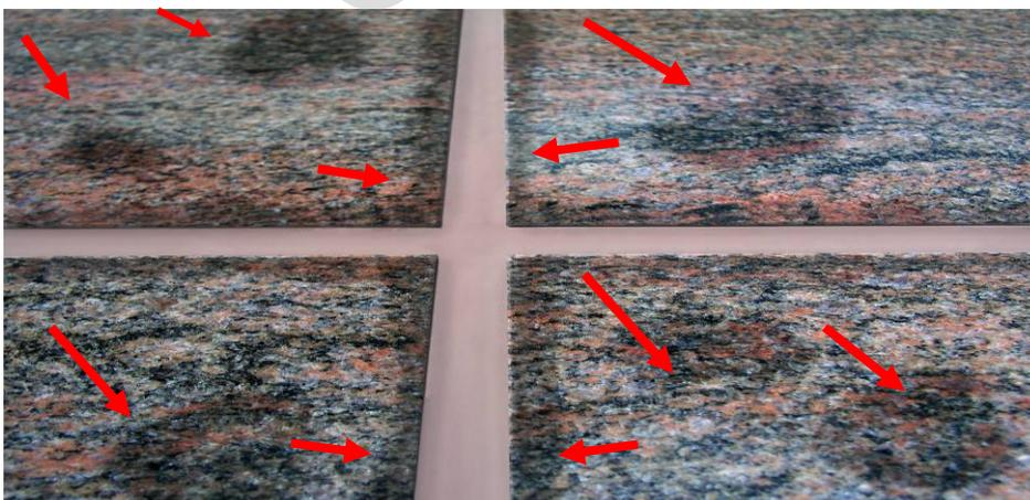
Abbildung 9: Starke Natursteinverschmutzung aufgrund eines nicht geeigneten Dichtstoffes. Zusätzlich starke Fleckenbildung durch Abstellen von z.B. Primerflaschen etc.
