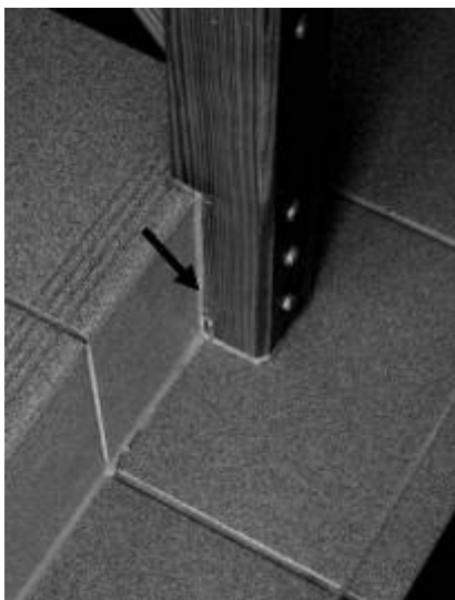
Рис. 12: Уплотнение между началом лестницы и настилом
