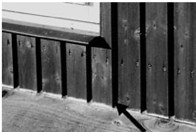
Рисунок 15: Сплоченность трещин в герметике из-за чрезмерного движения не размероустойчивых частей дерева.
