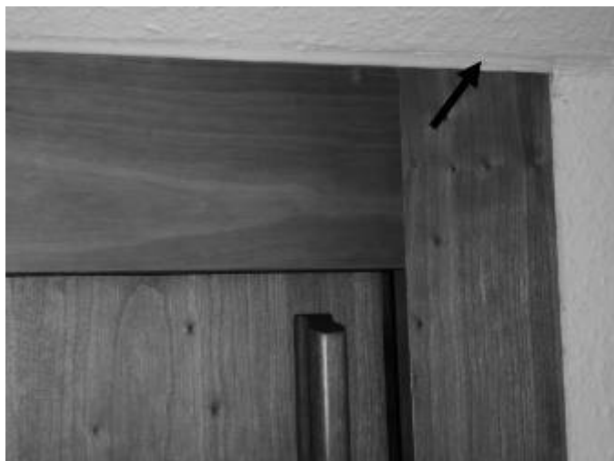
Рис. 9 Встроенный шкаф, уплотнение против ската крыши
