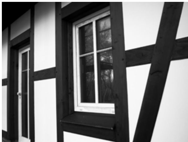
Рис. 5: Фасад готового дома с имитатом фахверка
