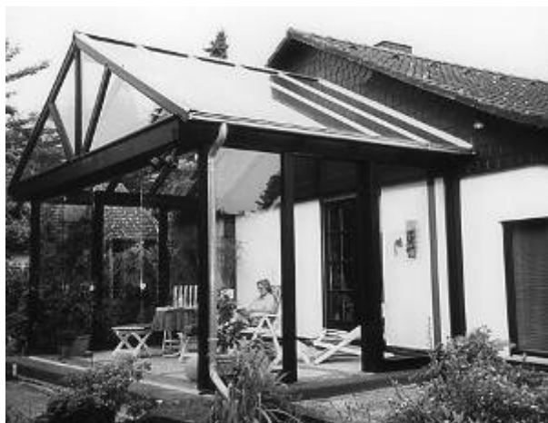
Рис. 6: Зимний сад, присоединение деревянных балок к начищенному строительному элементу
