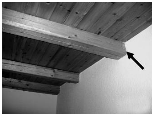
Рис. 10 Проведение потолочной балки в стену
