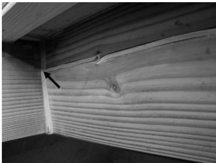
Рисунок 8 Заделывание трещин в древесине не рекомендуется
