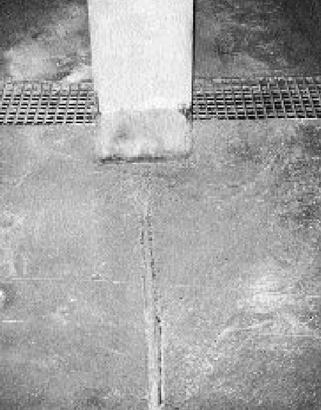
Typischer, „geplanter“ Schaden: alsch dimensionierte Bewegungsfuge in inem Parkhaus.
