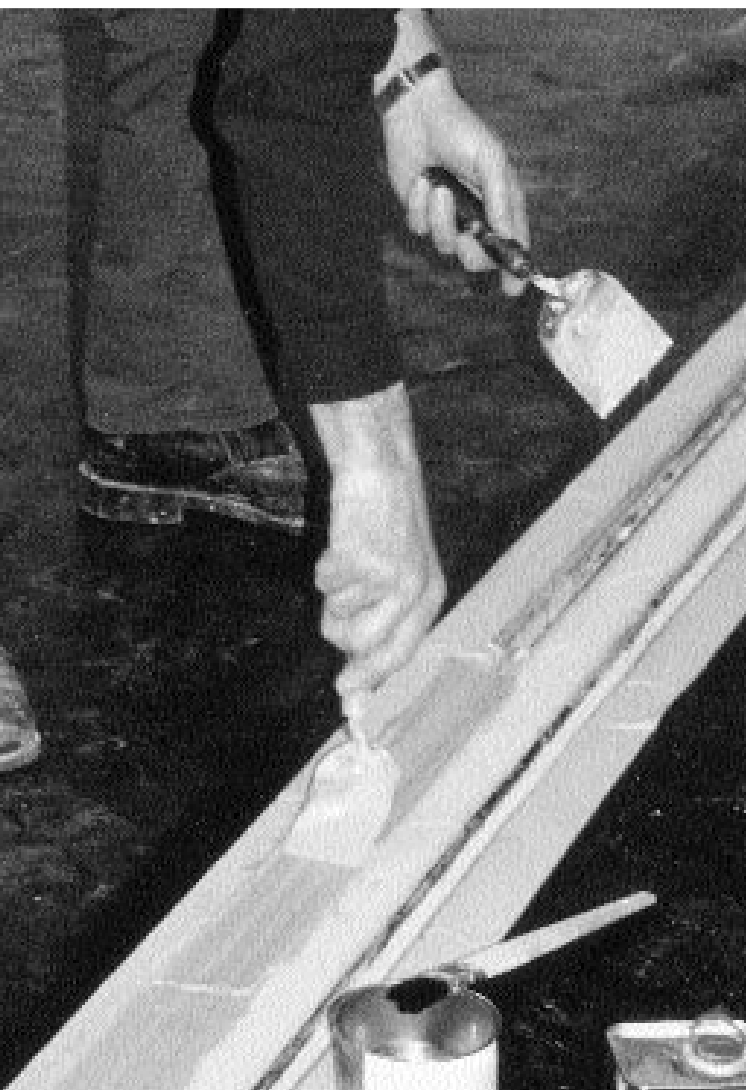
Nicht selbstverständlich: Fachgerechte erarbeitung eines zweikomponentigen ichtstoffes in einem Lager nach den orschriften des Wasserhaushaltsgesetzes.
