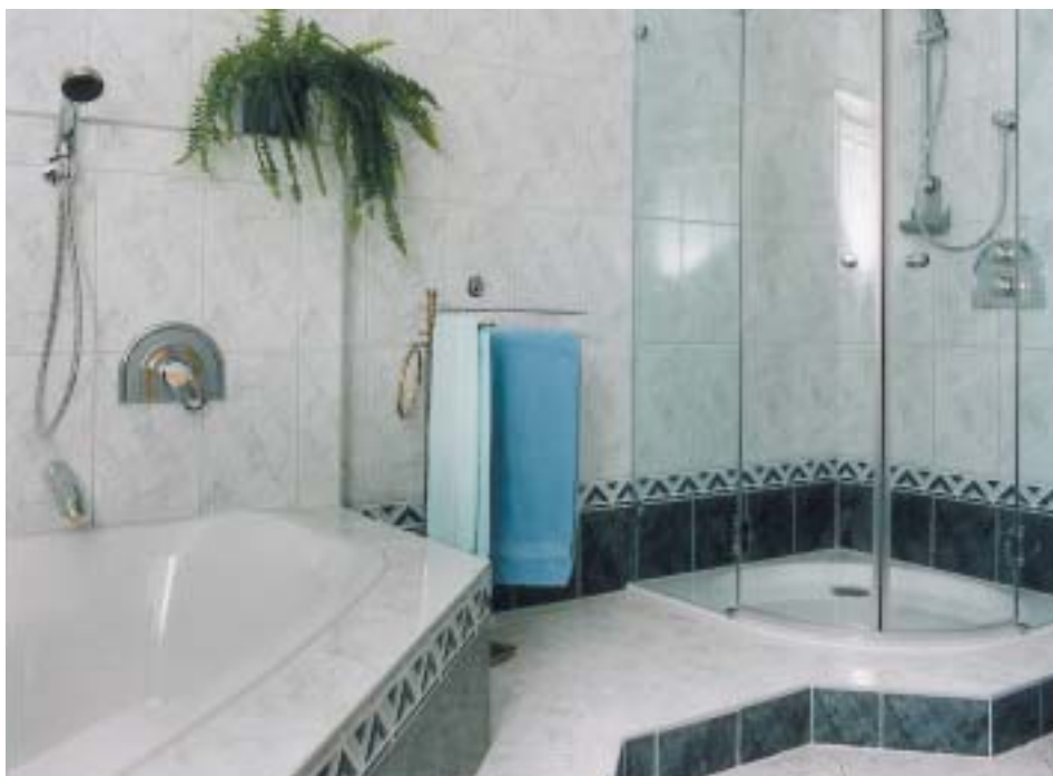
Sorgfältig ausgeführte Anschlußfugen zwischen Sanitäreinbauteilen wie Badewanne oder Duschwanne gewährleisten eine langfristig optisch ansprechende und funktionelle Verfugung.
