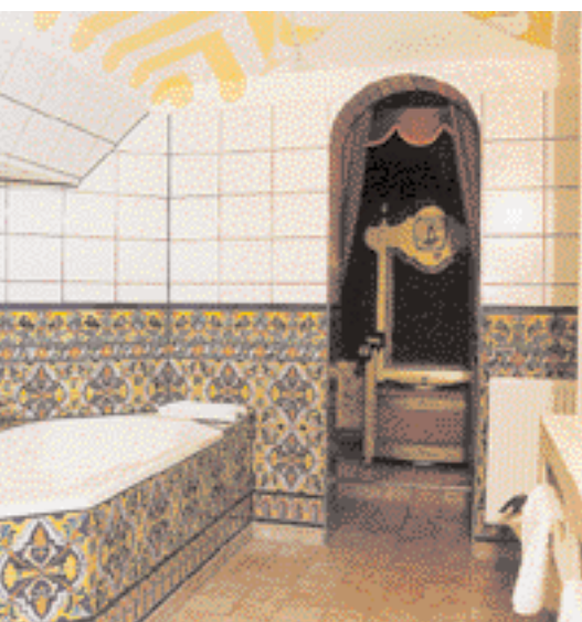
Teilansicht eines Badezimmers im Hotel „Spanischer Hof“: Um sicherzustellen, daß die Silikonfugen auch langfristig den optischen Ansprüchen genügen, wurden sie mit einem geruchsneutral aushärtenden Silikonmaterial mit fungizider Ausrüstung versehen.
