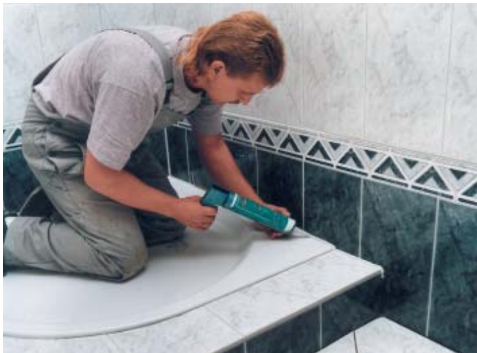
Im Bereich der Anschlußfugen zu Bade- und Duschwannen müssen die Arbeiten besonders sorgfältig ausgeführt werden, denn hier ist mit größeren Bewegungen zu rechnen.
