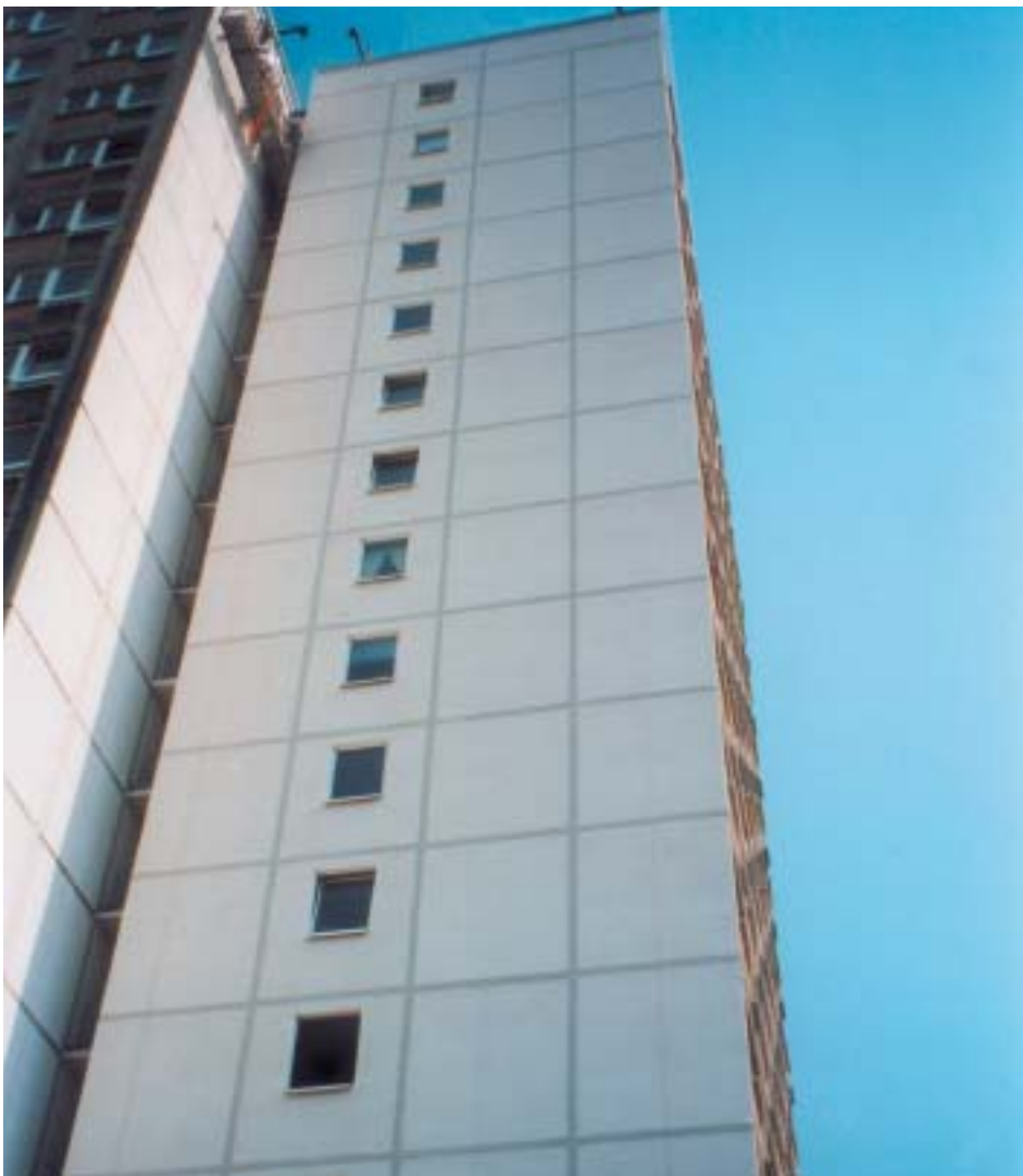
Farbige Fugenbänder bilden einen ästhetisch ansprechenden Kontrast zu den hellbeigen Fassaden.
