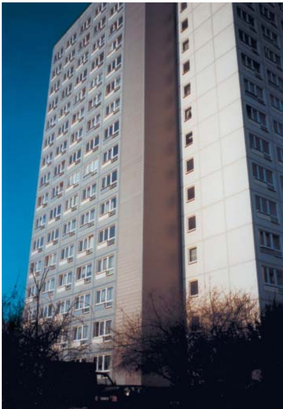
Im Wohngebiet um die Straße des 18. Oktober in Leipzig wurden 1998 insgesamt 1.365 Wohnungen in drei sechzehngeschossigen Hochhäusern des Typs „P 16“ mit der Systemlösung „Fuge-Farbe-Fläche“ instand gesetzt und modernisiert.
