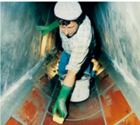
Verfugung einer mit Steinzeugplatten ausgekleideten Kanalsohle mit sulfatwiderstandsfähigem Spezial-Fugenmörtel.
