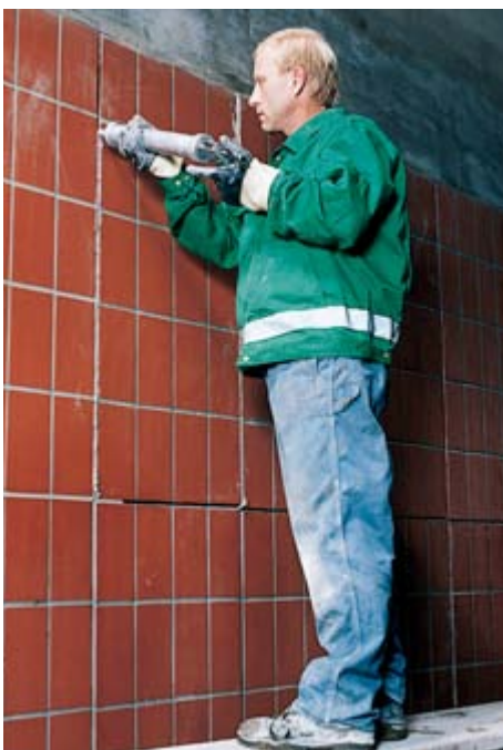
Chemikalienbeständig verfugen.
