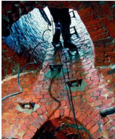
Abstieg zur Schachtsanierung auf frisch verankerten Steigeisen.
