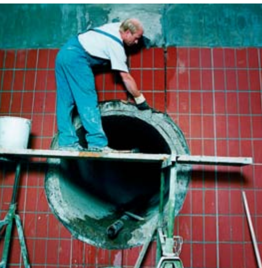
Passgenaues Einsetzen eines Platten-elements in das Kleberbett des Verlegemörtels.
